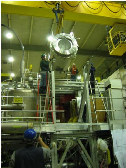
新たな超伝導電磁石を実験ホール内にインストールしている様子
